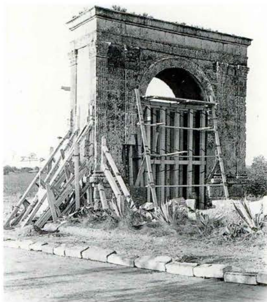
FIGURA 47. Treballs de restauració de l'arc, efectuats l'any 1936 (Fons documental del Servei del Patrimoni Arquitectònic Local de la Diputació de Barcelona, clíxé núm.: 32.796).
