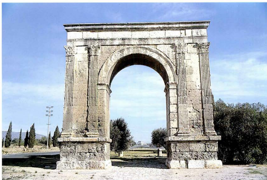
LÀMINA 1. Arc de Berà, façana meridional (fotografia Martín García).
